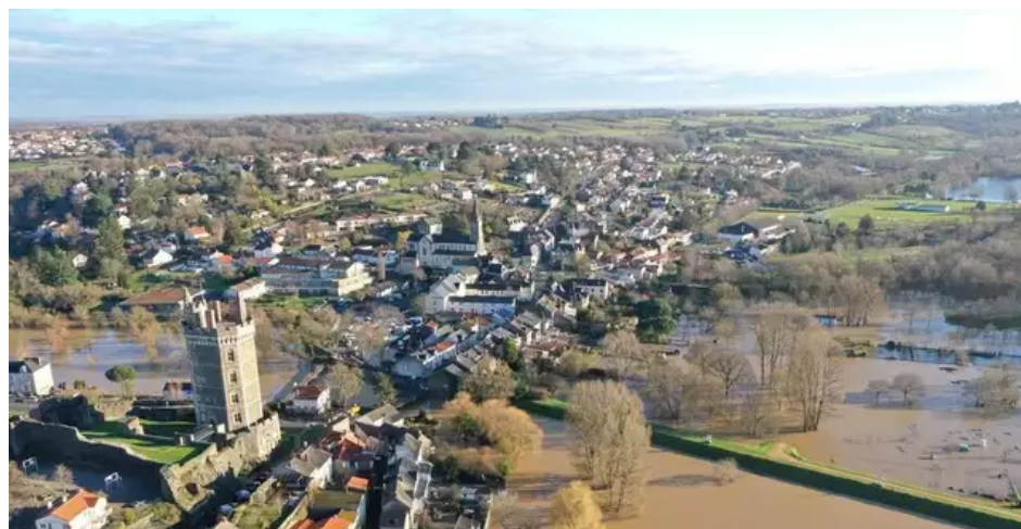
À Oudon, le tunnel qui mène à la gare SNCF est inondé. Les trains TER sur l'axe Nantes-Ancenis ne s'arrêtent pas ce mardi matin. © Hugues Lemonnier
