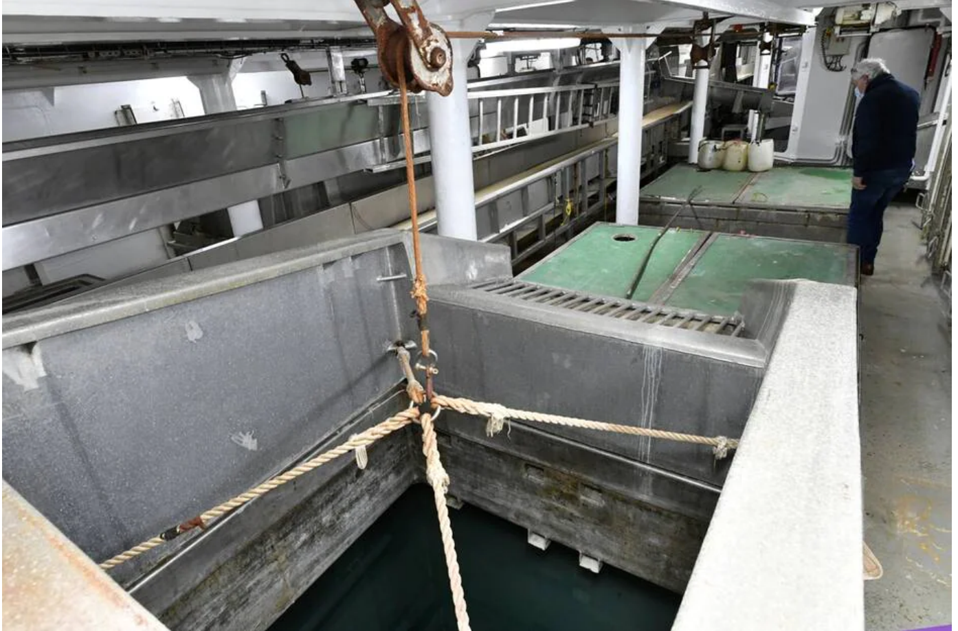
Les cuves sèches où le thon pêché par le Manapany est congelé à – 40 °. | THIERRY CREUX / OUEST-FRANCE
