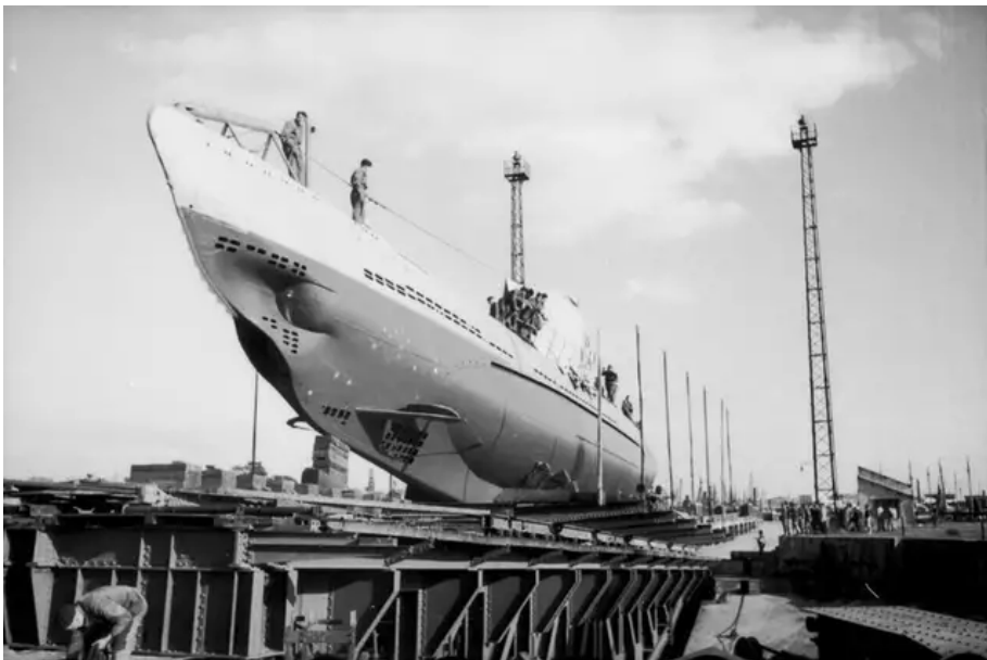
Septembre 1940. Le sous-marin allemand U-Boot 61 est monté sur le slipway de Keroman grâce au treuil et à la rampe inclinée puis sera mis à l'abri dans la cathédrale, le dom-bunker. © REGION BRETAGNE
