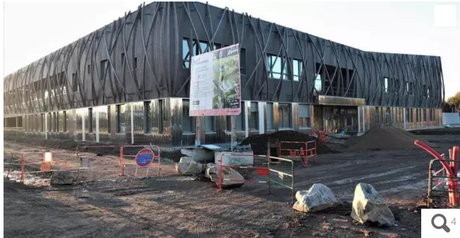
L'école Doulon-Gohards, située à l'est de Nantes (Loire-Atlantique), rue de la Papotière, devrait ouvrir ses portes à la rentrée de septembre 2023. Elle sera accompagnée d'un gymnase, d'un centre aéré, d'un terrain multisport et d'une salle polyvalente. © Ouest-France
