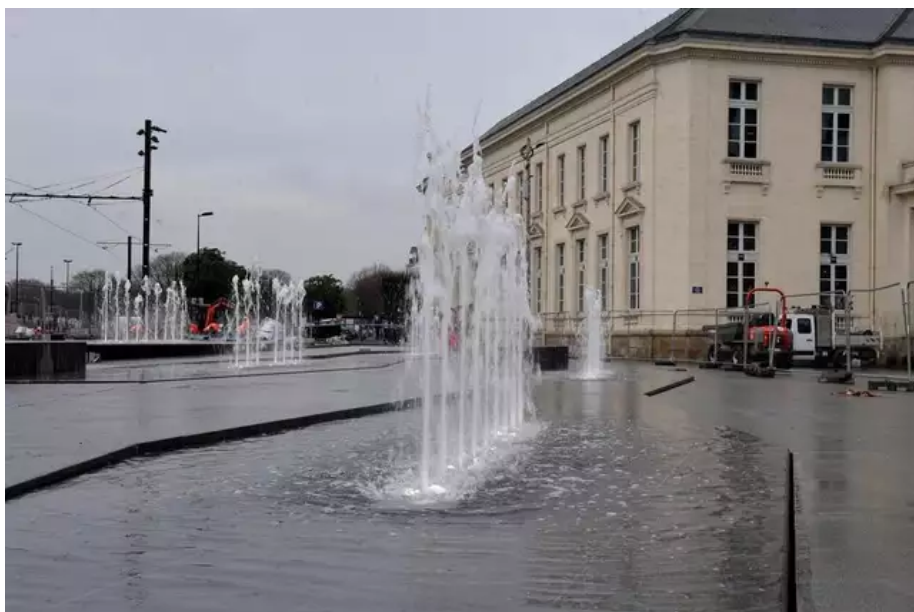
Des essais sont réalisés sur les fontaines Commerce-Feydeau. © Photo PO-Nathalie Bourreau
