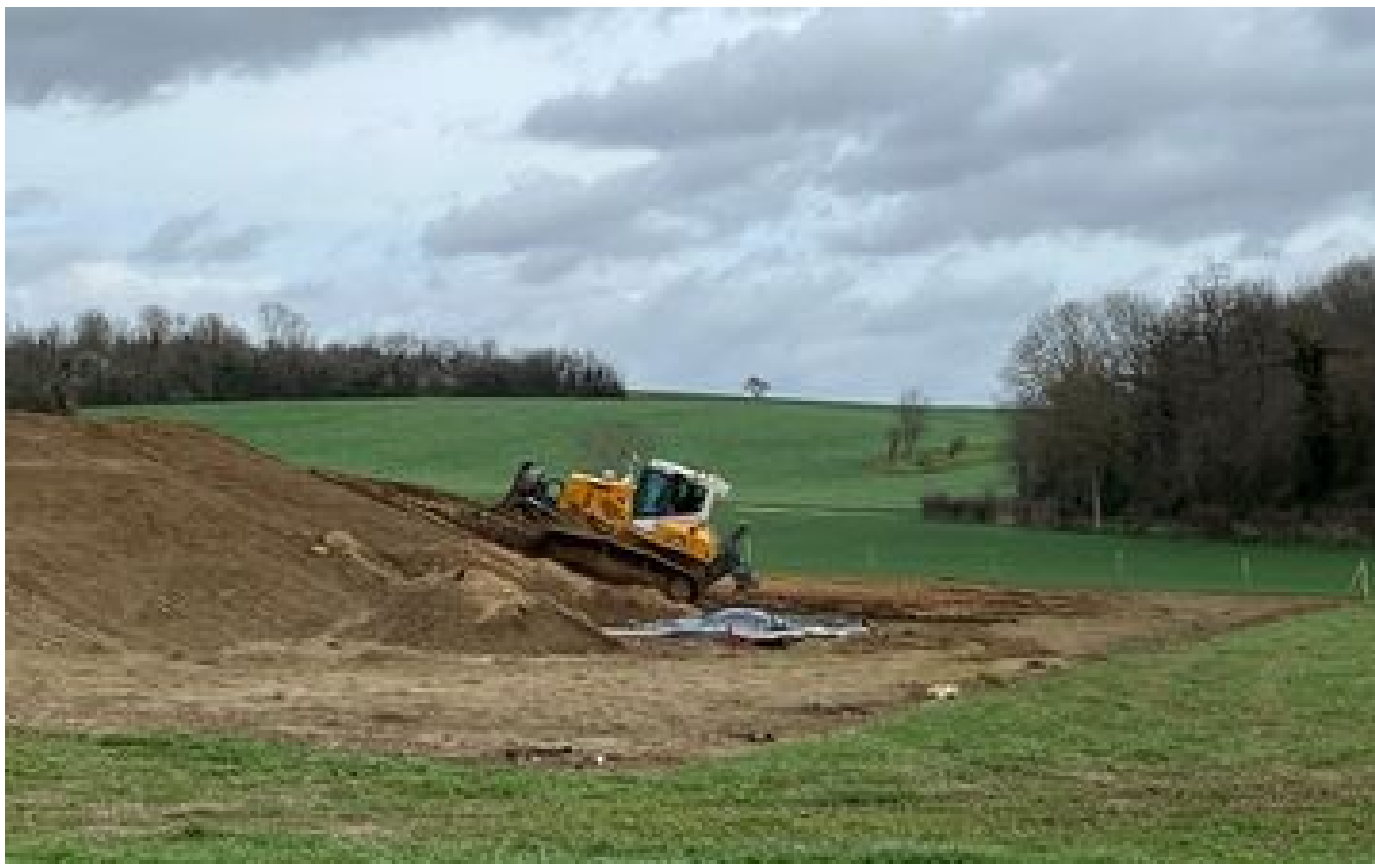
Dans le Val-d'Oise, la seule mégabassine d'Île-de-France en passe d'être rebouchée P
