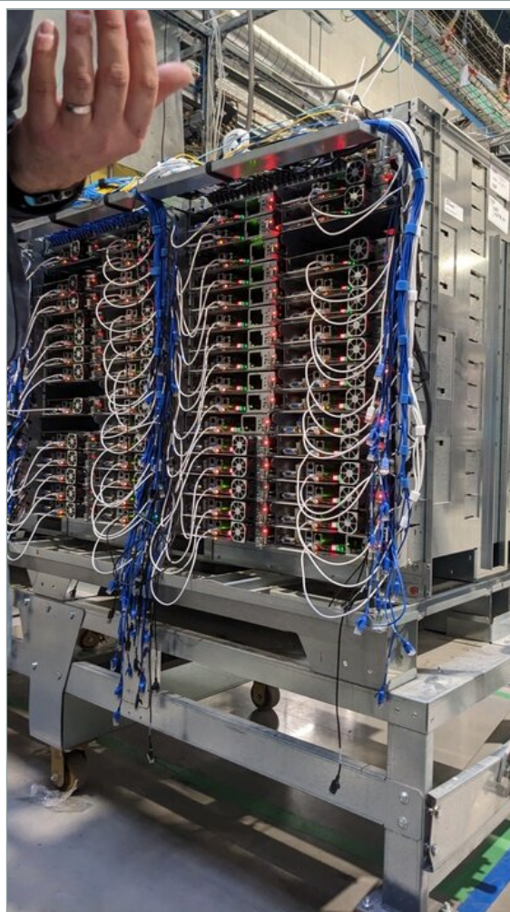
Une baie vide, une baie avec du réseau et une baie montée
