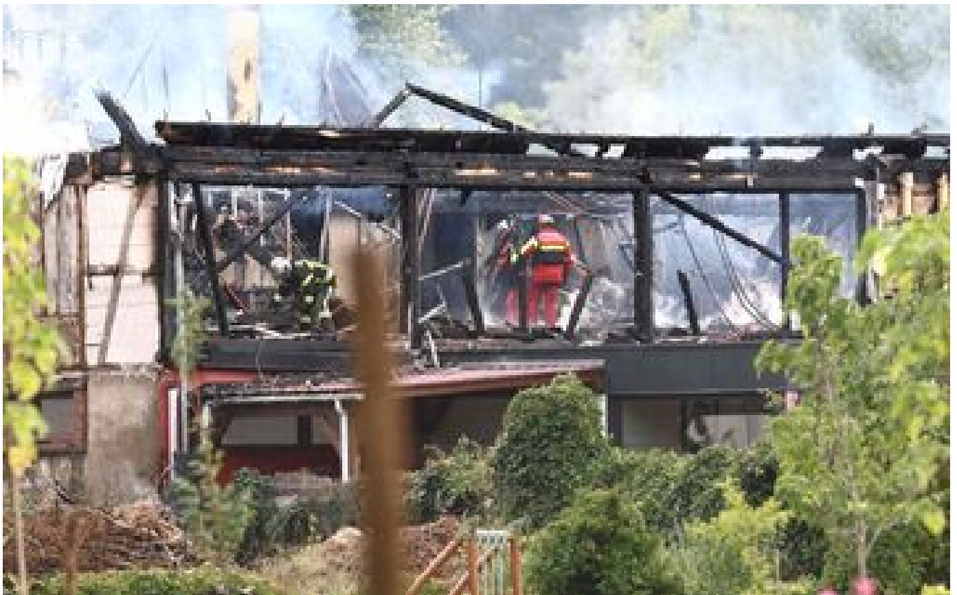
Incendie en Alsace : le gîte « n'était pas aux normes »... Ce que l'on sait au lendemain du drame
