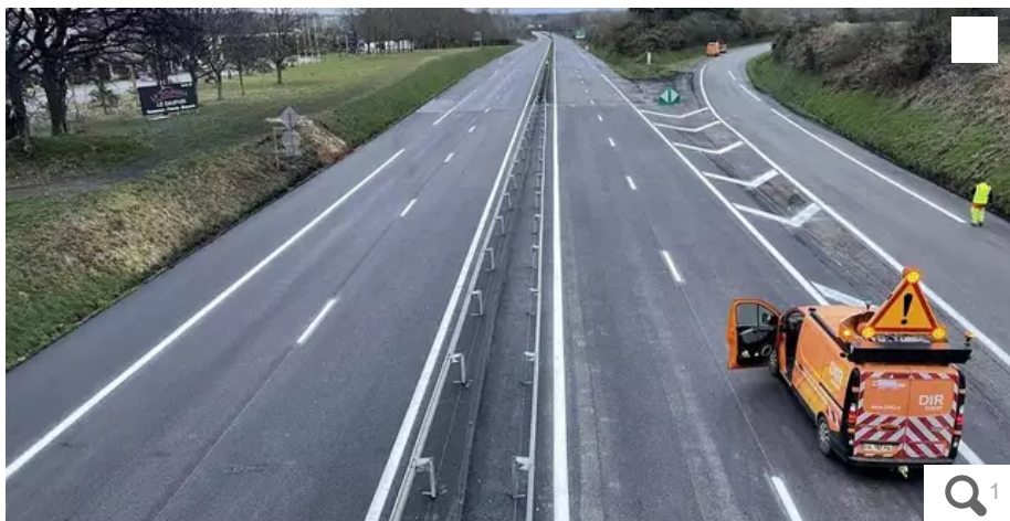
La RN165 refaite à hauteur de la zone du Porzo à Kervignac, hier en fin d'après-midi. © Ouest-France
