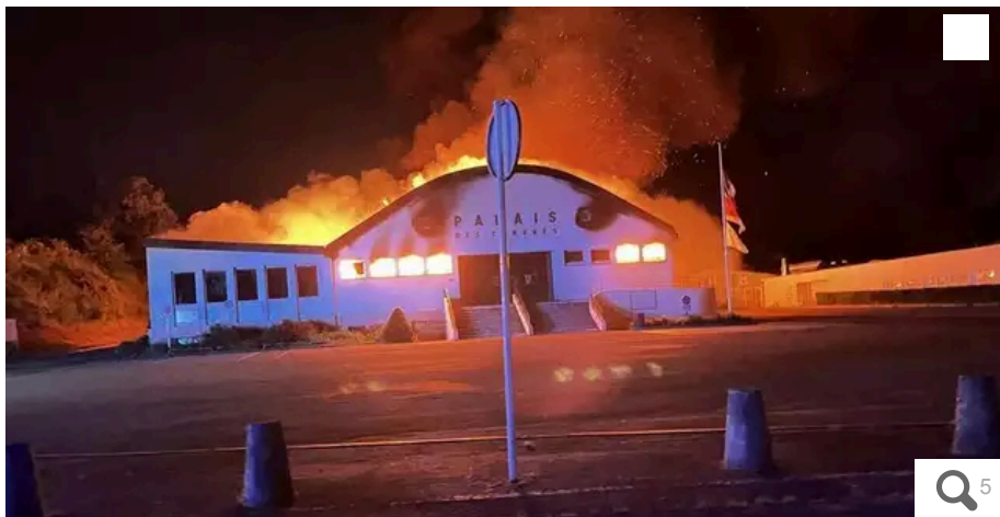
Vers 3 h 50, ce vendredi 24 mai, les pompiers ont été appelés pour un incendie au palais des congrès du Loroux-Bottereau. © DR
