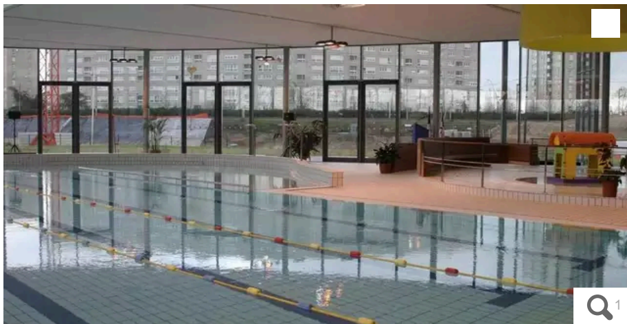
Depuis l'été 2022, la piscine de la Petite-Amazonie subit d'importants travaux. © Archives Ouest-France
